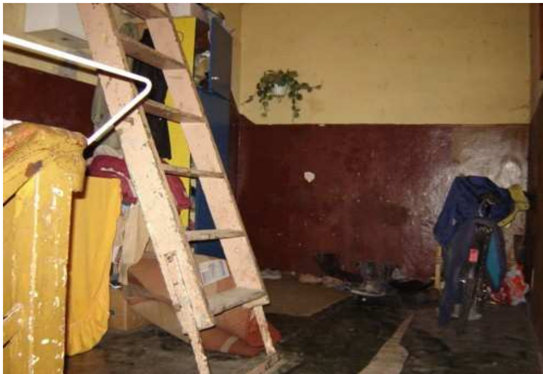
Fot. 3. Wnętrze budynku przeznaczonego do rewitalizacji
