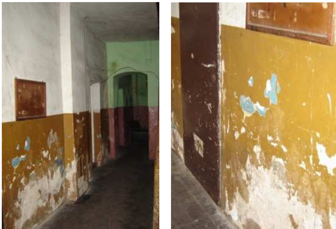
Fot.2. Parter budynku przeznaczonego do rewitalizacji
